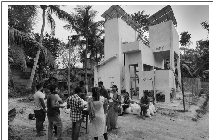
Fertiggestellte Trinkwasseraufbereitungsanlage in Rasui. Die Komponenten sind durch Abkürzungen kenntlich gemacht (SSF- Slow Sand Filter, CWT – Clear Water Tank, DIGF – Dynamic Intake Gravel Filter, BT – Buffer Tank. Nicht zu sehen/beschriftet: RSF – Rough Sand Filter, ACF – Activated Carbon Filter) © Indienhilfe
