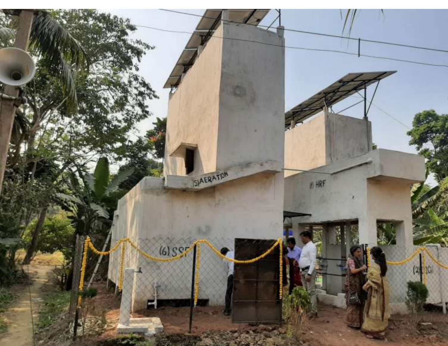
Fertige Trinkwasser-Aufbereitungsanlage und Teich (Wasserspeicher)
